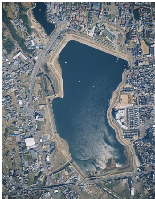
改修を終えた狭山池 提供：大阪府河川室
