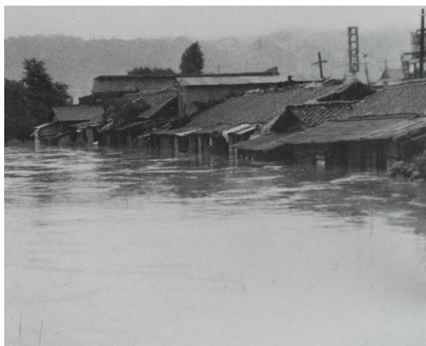
中之島の浸水状況（昭和 47 年）
