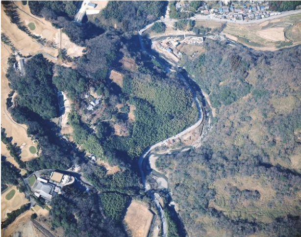
安威川ダムサイト 提供：大阪府河川室
