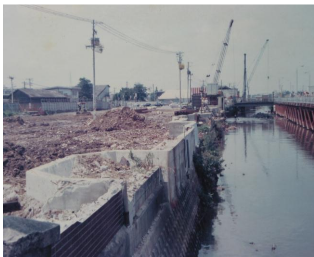
家屋撤去後に残ったコンクリート擁壁
