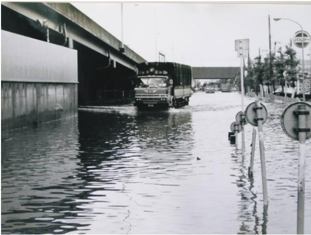
中央環状線の冠水（昭和 58 年）
