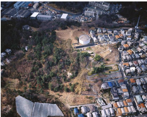
対策が完了した西旭丘の地すべり 提供：大阪府河川室
