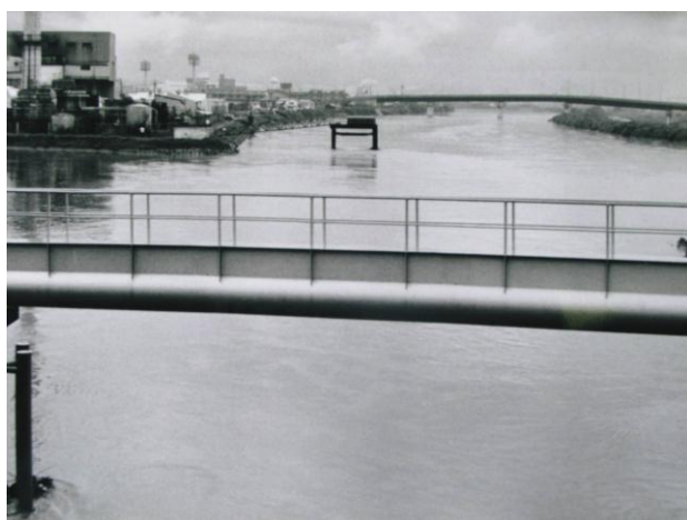
昭和 58 年安威川の出水状況（中環より上流）
