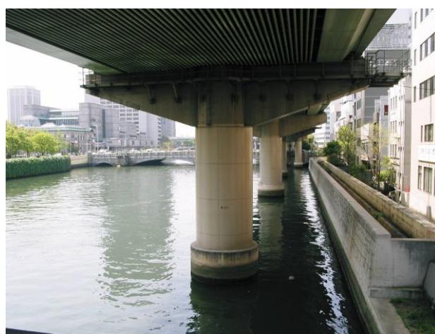
阪神高速道路の橋脚
